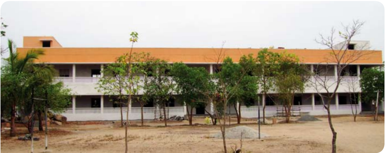
Das fast fertig gestellte neue Schulhaus Ende April.
